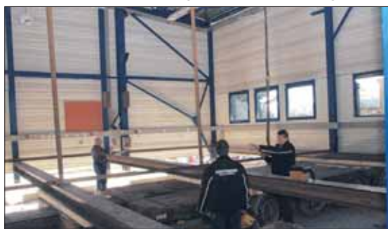
Einblick: Stahlträger sorgen für Stabilität. Die Halle liegt schon auf dem Tieflader.
