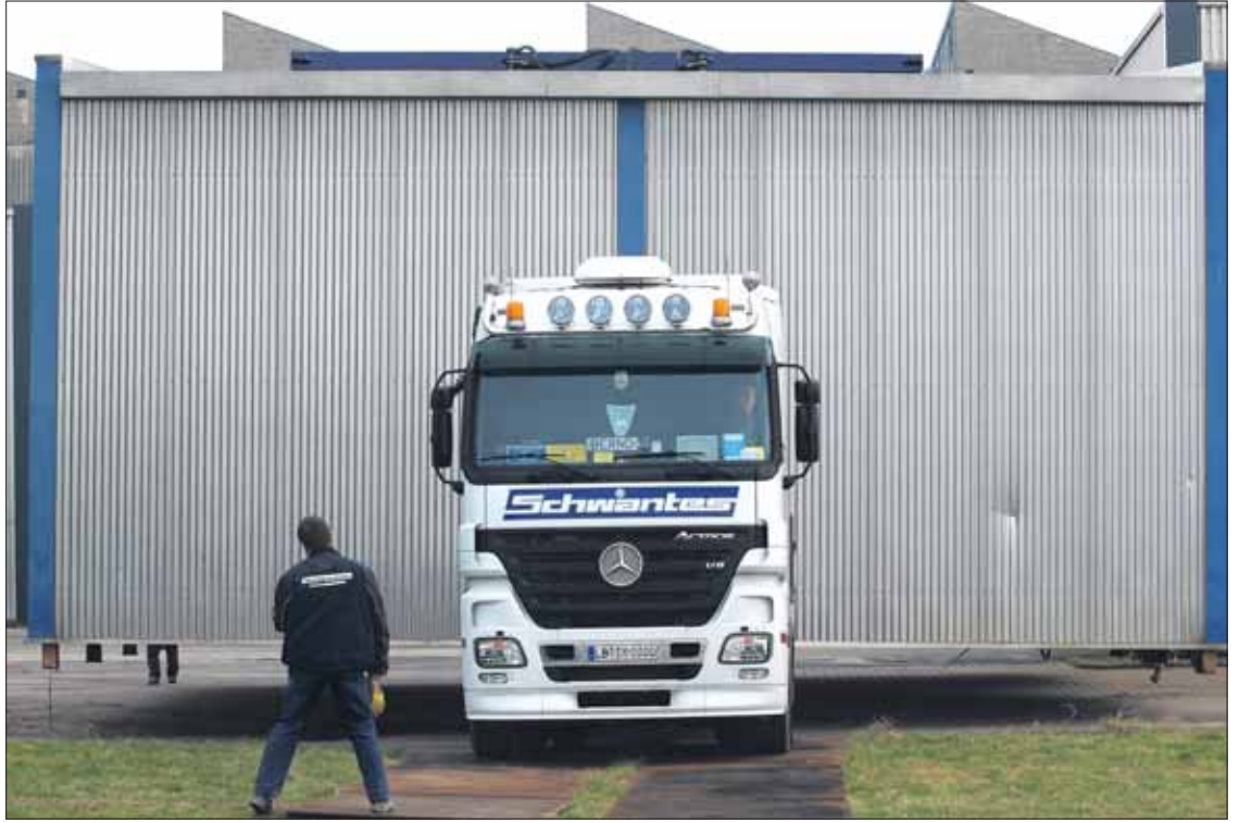
Formatfüllend: Die Halle misst 11,50 mal 13 Meter und wiegt 20 Tonnen. Stahlplatten sorgen dafür, dass sich der Lkw auf dem Grünstreifen nicht festfährt. Fotos: Goertz
